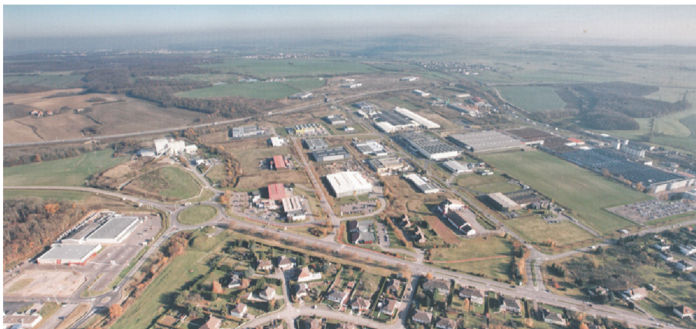
Photo aérienne de la zone artisanale
