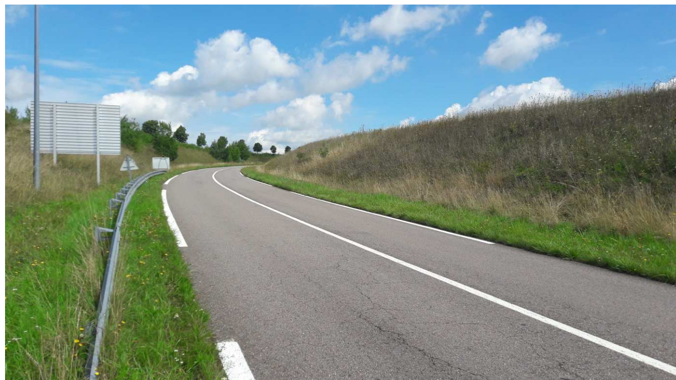
Le paysage de l'infrastructure – le tunnel des talus routiers
