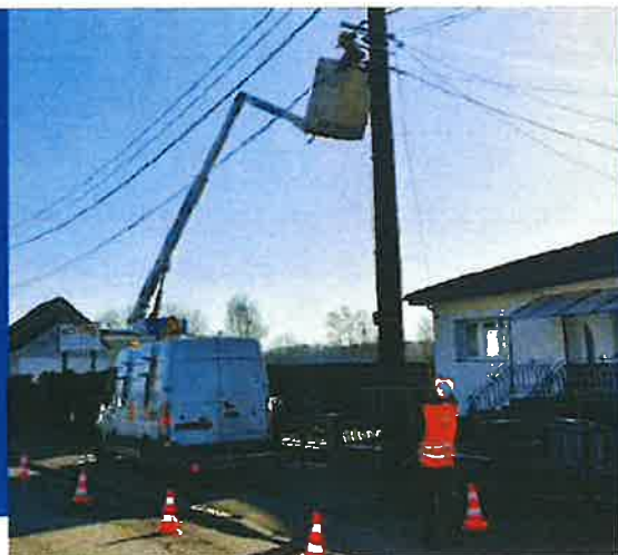
Démontage du câble coaxial sur la commune de Faulquemont
